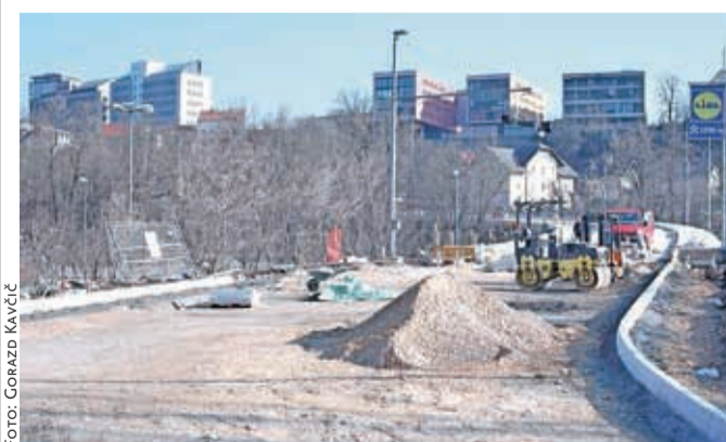
Dela na nadvozu nad Savskim otokom se zaključujejo.
