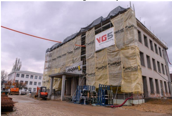
Foto 1: Prenova vzhodnega krila objekta
