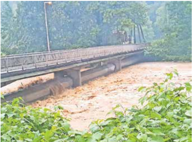
V hudi ujmi v začetku avgusta je prišlo do poškodb betonskega plašča okoli kanalizacijske cevi pod mostom pri Planiki. / FOTO: ARHIV MOK
