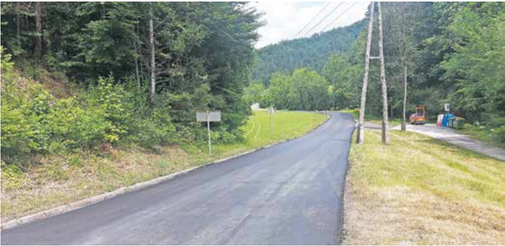
Obnova cestišča Nemilje–Podblica (KS Podblica) / Foto: MOK
