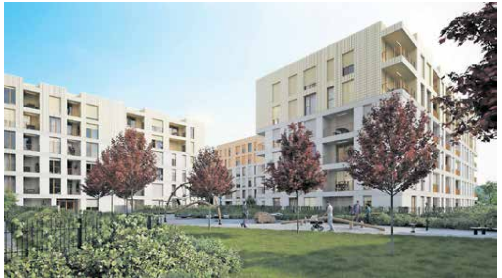
Investitor v sosesko Kranjska iskrica je kranjska družba Emeco nepremičnine.
