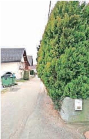
Nepravilno obrezana živa meja posega v prosti profil ceste.
