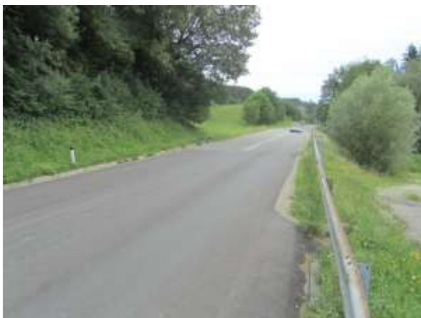
Slika 3: levo vkopna brežina, desno nasip, ki je bil utrjen s kamnito zložbo.
