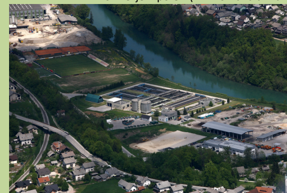
Centralna čistilna naprava Kranj (Foto: Gorazd Kavčič)
