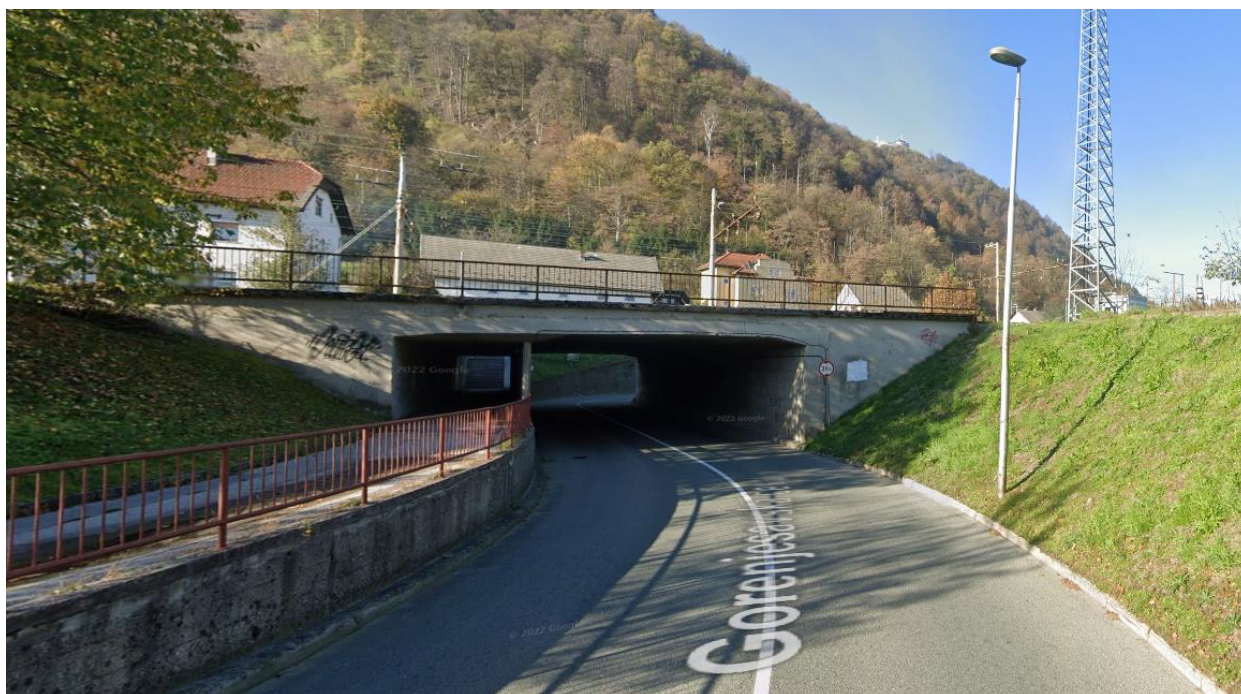
Cesta Kranj–Besnica – podhod pod železniško progo
