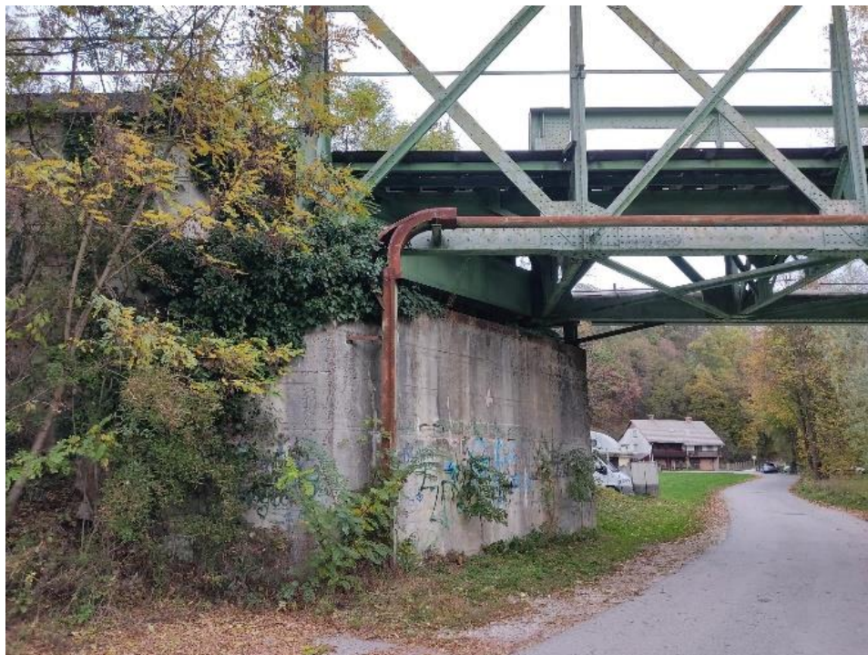
Stena pod železniškim mostom
