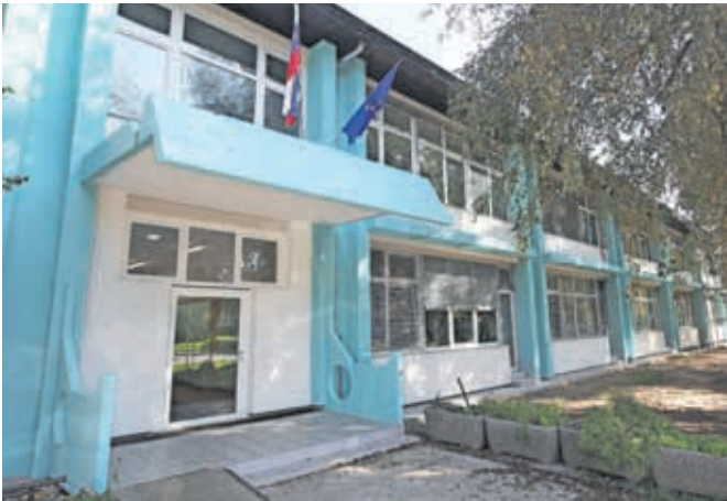
Energetska sanacija poteka tudi na objektu OŠ Simona Jenka. / FOTO: GORAZD KAVČIČ
