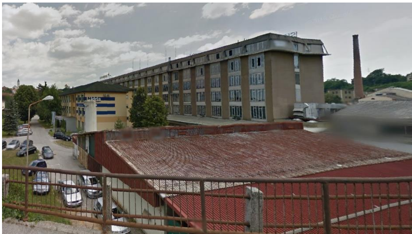
Slika 21: Pogled proti južnemu robu območja obravnave proti Iskraemeco in Hidria – območje gospodarske cone (Vir: Google Map)
