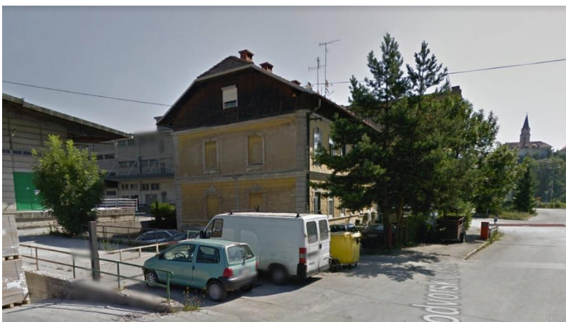
Slika 9: Pogled s Kolodvorske ceste na večstanovanjsko stavbo na vstopnem območju (Vir: Google Map)
