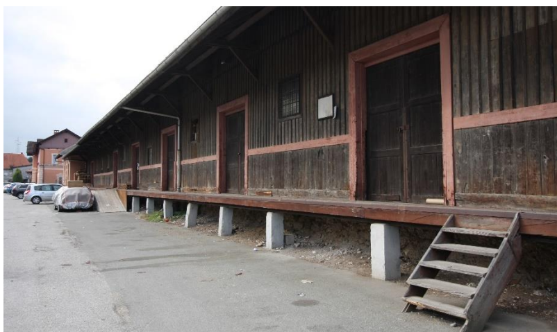
Slika 15: Leseno skladišče ob postajnem poslopju (lastni vir)
