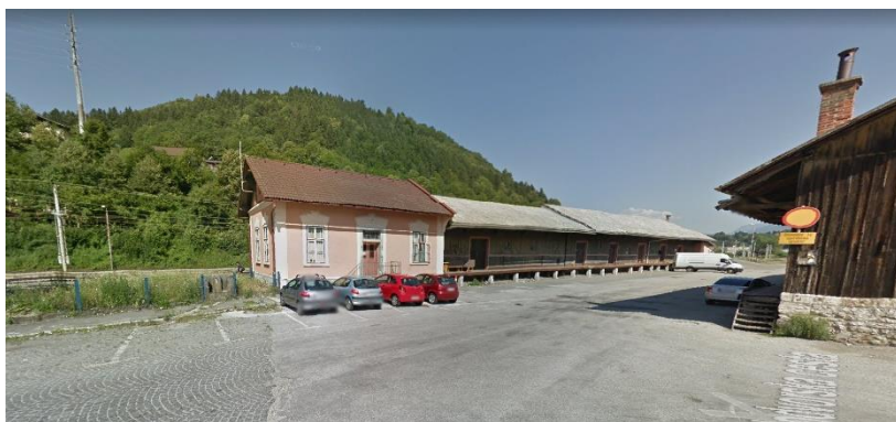
Slika 26: Kranj - Železniška postaja EŠ 26567 – leseno skladišče (Vir: Google Map)
