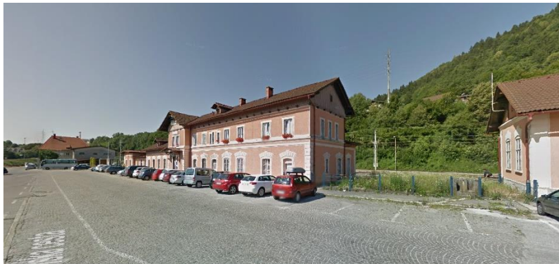
Slika 27: Kranj - Železniška postaja EŠ 26567 – parkovni element (Vir: Google Map)
