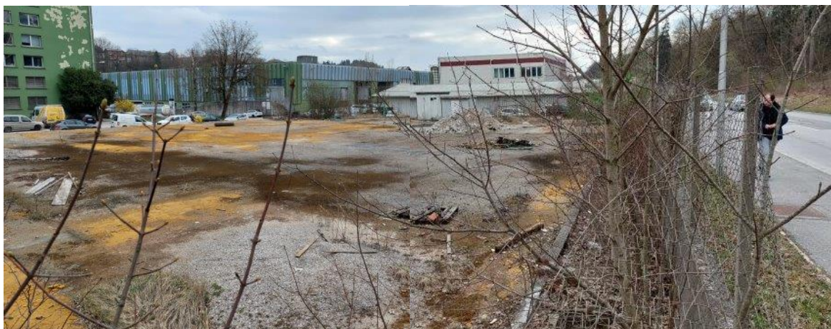
Foto 2: Panorama na območje LP s SZ (razviden rob AB talne plošče, obstoječa ograja in hodnik ter cesta ob zahodnem robu območja).
