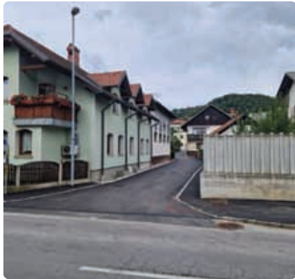
OBNOVLJENA GASILSKA ULICA S CESTO IN KOMUNALNO INFRASTRUKTURO V STRAŽIŠČU
