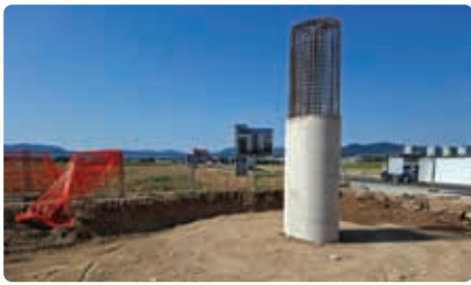
GRADNJA NADHODA PRI TUŠU
