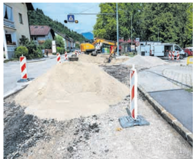
Gradbena dela na Delavski cesti v Stražišču / FOTO: PRIMOŽ PIČULIN
