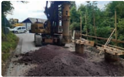
SANACIJA PLAZU V ČEPU LJAH
