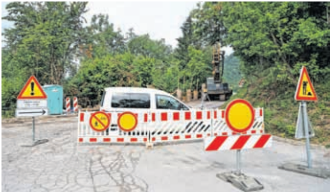
Med izvedbo del bodo občasno potrebne popolne zapore cest. / FOTO: TINA DOKL
