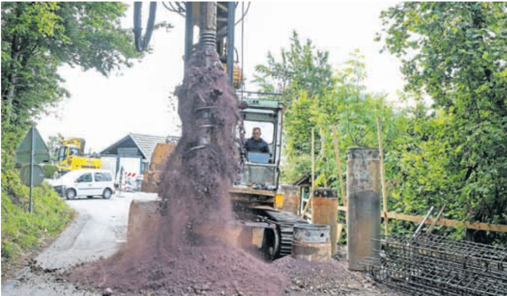
Najzahtevnejša dela predstavljata izgradnja pilotne stene in predhodna zaščita temeljev stanovanjskega objekta. / FOTO: TINA DOKL
