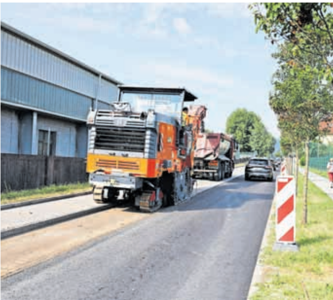
Na delu Škofjeloške ceste v Stražišču menjajo asfalt in tamponsko podlago na vozišču. / FOTO: TINA DOKL
