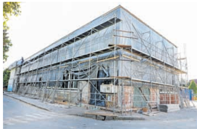
Rekonstrukcijo šole bodo predvidoma končali marca 2025.
