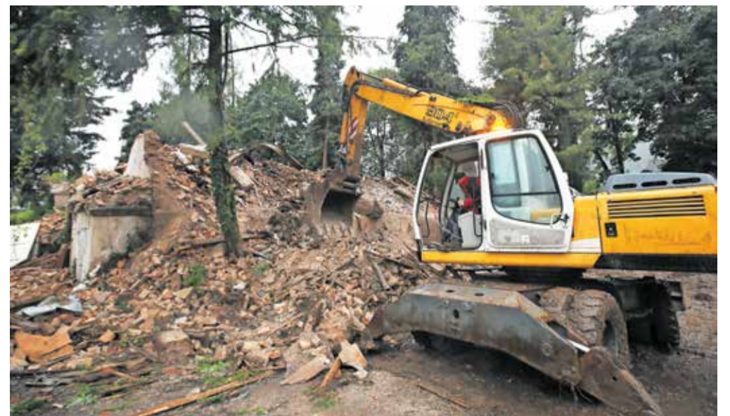
Propadajoč objekt, v katerem je deloval prvi vrtec v Kranju, so porušili v začetku oktobra.
