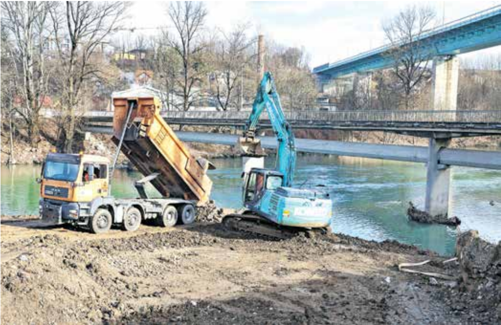
Gradnjo mostu so začeli z zaježitvijo reke Save na desnem bregu. / FOTO: TINA DOKL
