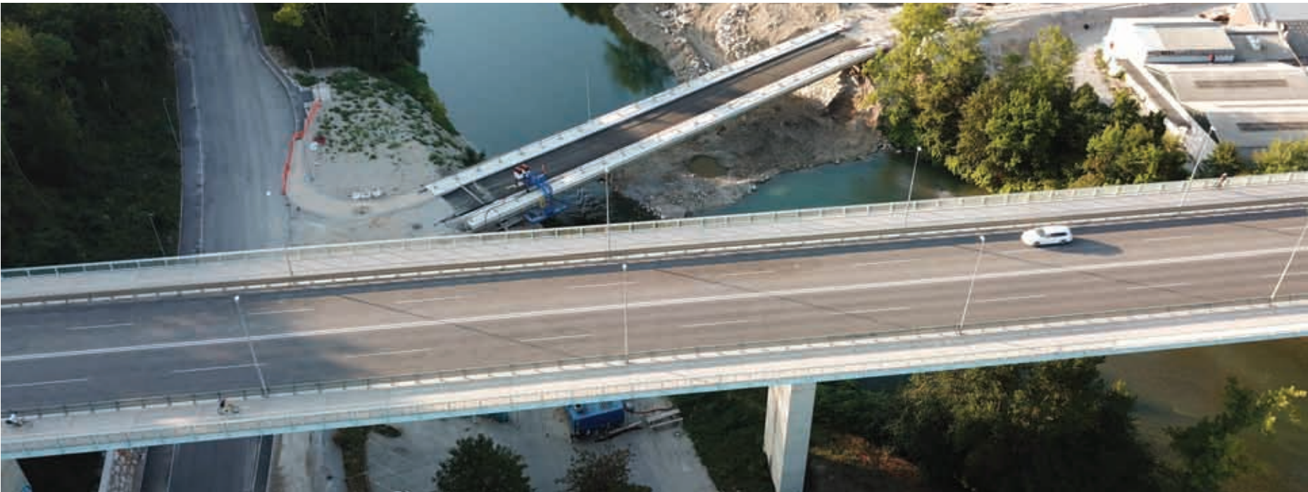
NOV MOST PRI PLANIKI V ZAKLJUČNI FAZI — DEL CELOVITE REKONSTRUKCIJE SAVSKE CESTE
