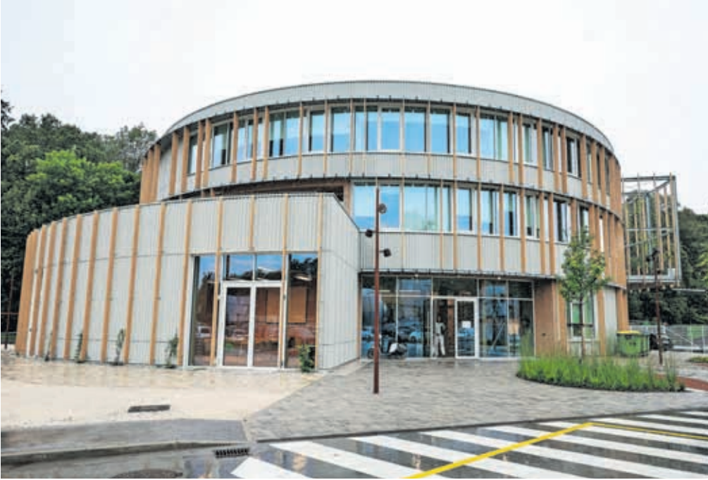
Nova poslovna stavba Komunale Kranj in izobraževalno središče v Parku Zarta / FOTO: TINA DOKL
