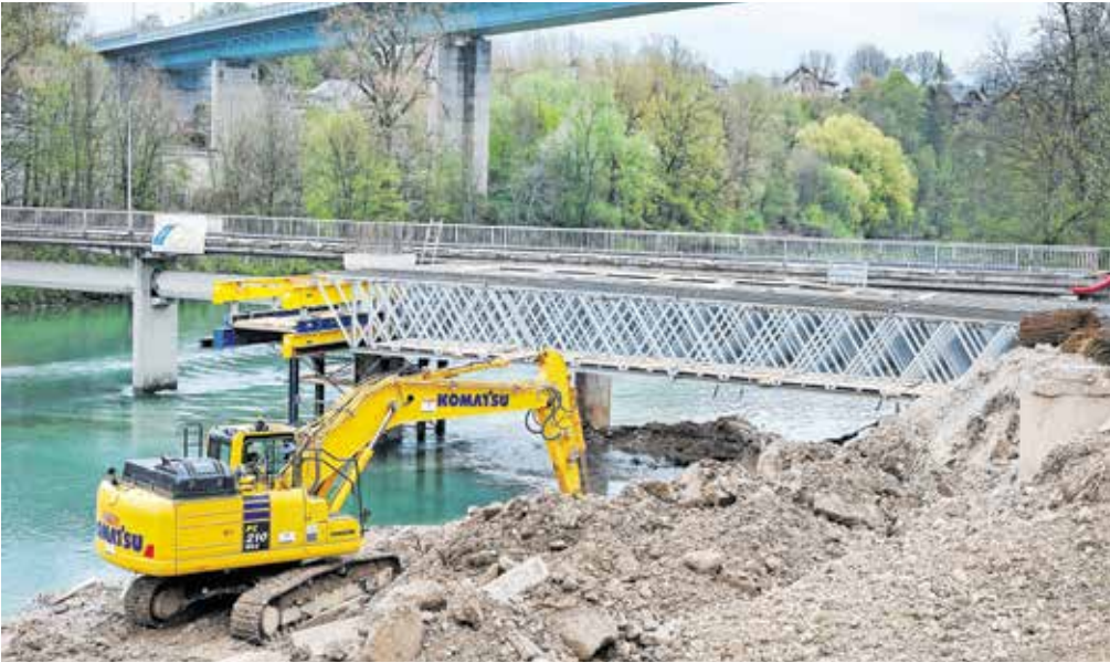
Za izgradnjo novega mostu pri nekdanji Planiki bosta Evropska unija in država prispevali skupaj 1,3 milijona evrov. / FOTO: TINA DOKL
