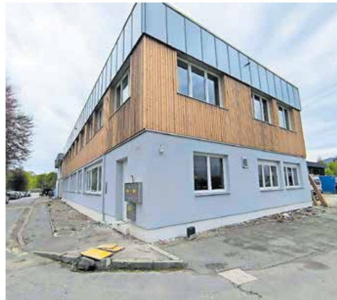
Dela na dozidavi in rekonstrukciji Osnovne šole Helene Puhar so v zaključni fazi. / Foto: MOK
