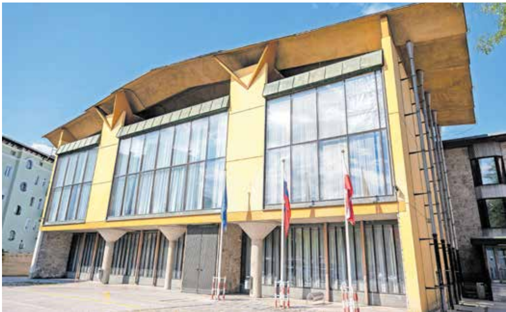
Okna 65 let stare Ravnikarjeve stavbe, kjer domuje kranjska občina, so močno dotrajana in energetska potratna. / FOTO: PRIMOŽ PIČULIN
