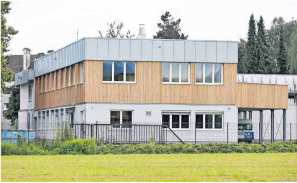
Končali so tudi gradnjo prizidka k Osnovni šoli Helene Puhar Kranj. / FOTO: TINA DOKL
