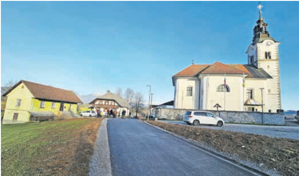
Rekonstrukcijo lokalne ceste Na Vidmu v Zgornji Besnici so končali ta mesec. / Foto: MOK
