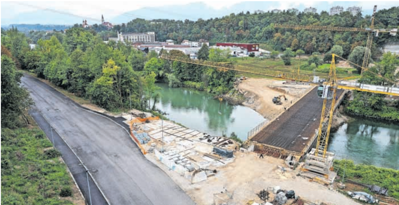
Rekonstrukcija Savske ceste in gradnja novega mostu pri nekdanji Planiki / FOTO: TINA DOKL
