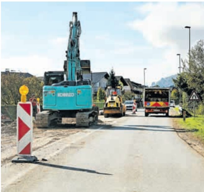
Kanalizacijo od Mlake do Golnika so začeli graditi aprila.
