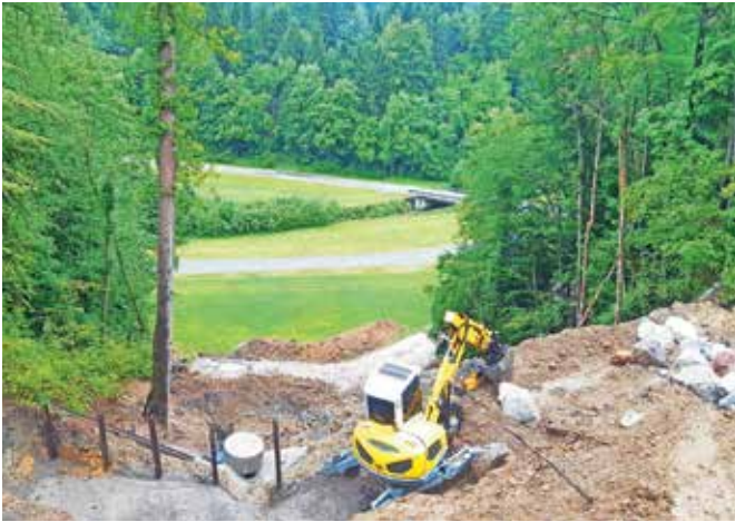
Ureditev odvodnjavanja in dostopne poti na območju plazu Njivica pod lokalno cesto Češnjiški most–Njivice / FOTO: MOK
