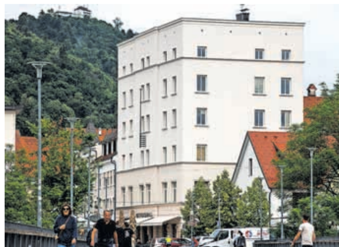
Celovita sanacija fasade na objektu Glasbene šole Kranj je končana. / FOTO: MATIČ ZORMAN
