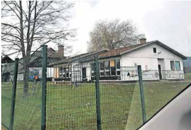
Vrtec Biba pred obnovo ... / Foto: MOK
