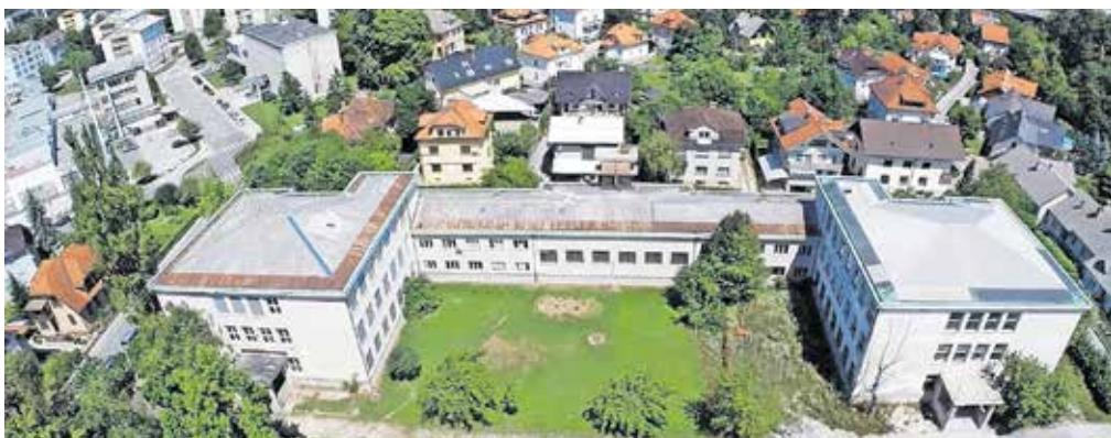
PŠ Center pred obnovo ... / Foto: MOK
