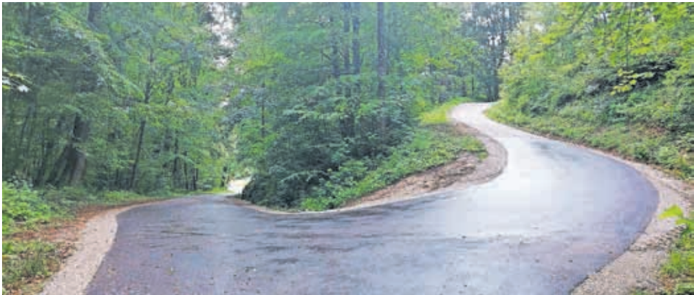
Na novo asfaltirana serpentina na Babnem Vrtu / FOTO: MOK
