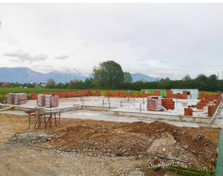
Temelji novega vrtca
