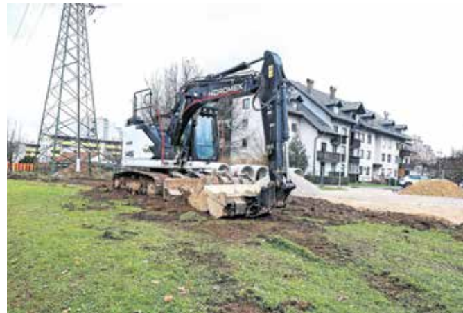
Trenutno poteka gradnja parkirišča z 62 parkirnimi mesti.
