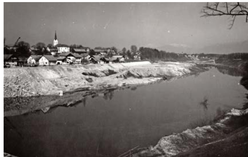
Mavčiče na levem bregu Save med gradnjo hidroelektrarne, leto 1986 (Foto Drago Holynski, fototeka Gorenjskega muzeja)
