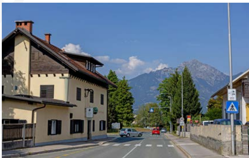
Cesta na Brdo s pogledom na Storžič, leto 2024 (Foto Anže Krže, arhiv Mestne občine Kranj)
