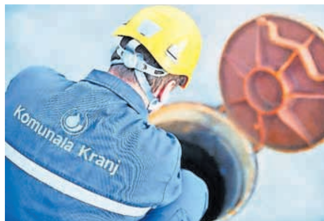
Odpadno jedilno olje, ki konča v straniščnih školjkah ali odtokih, povzroča veliko težav v kanalizacijskem omrežju. / Foto: SAMO PAUŠER
