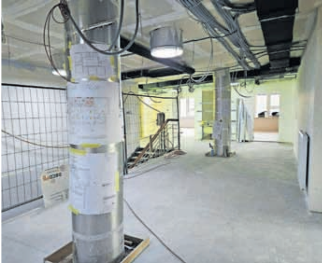
V stavbi nekdanje trgovske šole potekajo gradbena dela od lanske pomladi. / Foto: MOK
