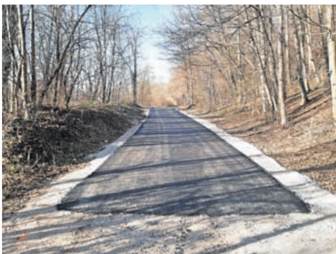
Asfaltiranje odseka ceste Struževo-Polica v KS Struževo (participativni proračun) / Foto: MOK
