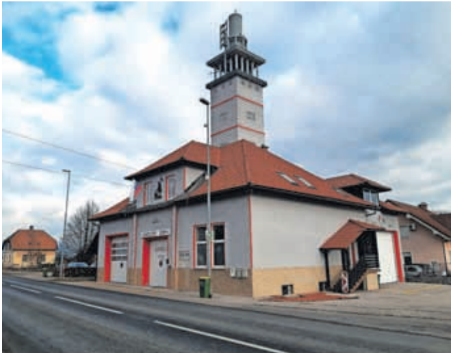
Sanacija strehe na gasilskem domu v Bitnjah (8. člen) / Foto: MOK
