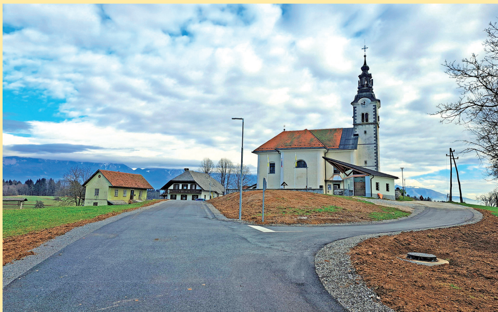
Nova lokalna cesta pri cerkvi v Zgornji Besnici / Foto: KS Besnica
