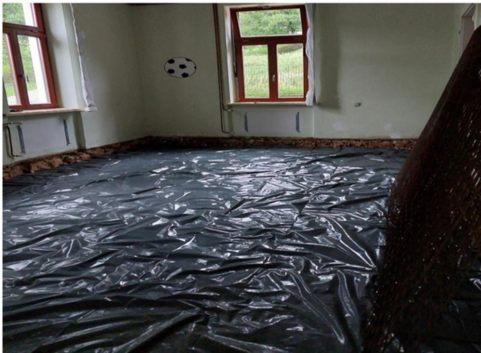
Telovadnica med obnovo
