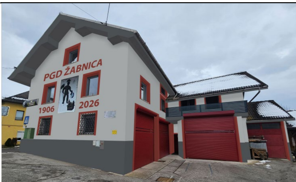
Gasilski dom po obnovi
